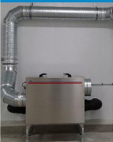
**Pour les versions ICF** (installés à l'intérieur de la chambre négative), les conduits du circuit d'air de régénération devront être isolés, des clapets d'isolement installés en amont et en aval et un filtre à air placé à l'aspiration.
